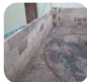
570 混凝土修补剂用于柴油储罐导流槽的表面防护。
