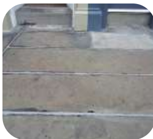
梯道使用570 混凝土修补剂增强 XF
