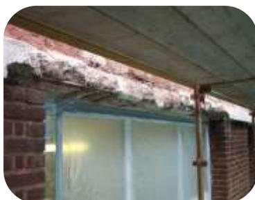
受损的混凝土窗台使用571超轻混凝土修补剂修复。
