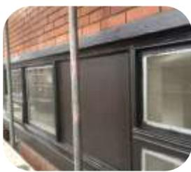
横梁使用571 超轻混凝土修补剂修复。
