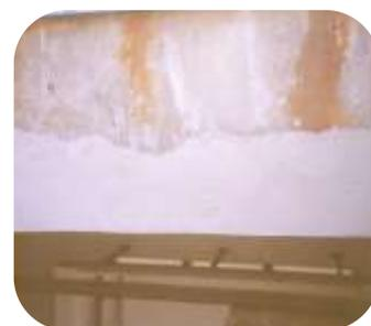
顶部混凝土结构使用571超轻混凝土修补剂重建。
